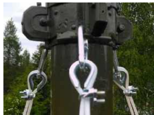
Рисунок 9 – Узлы крепления такелажа для растяжки мачты ВГ.
